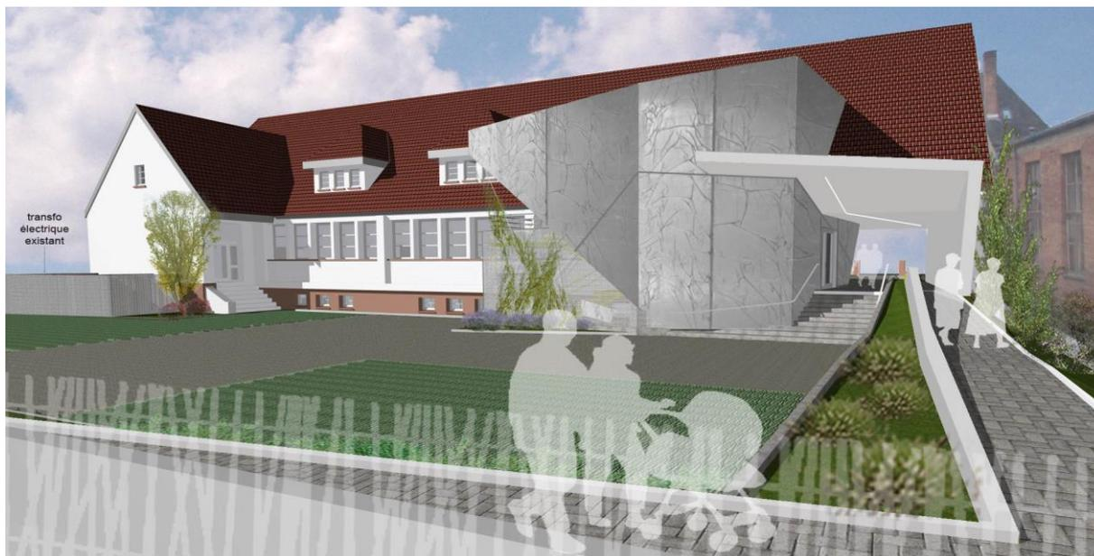
Habillage de la cage d'escalier en béton : Il est précisé que ce sont des panneaux en béton.
