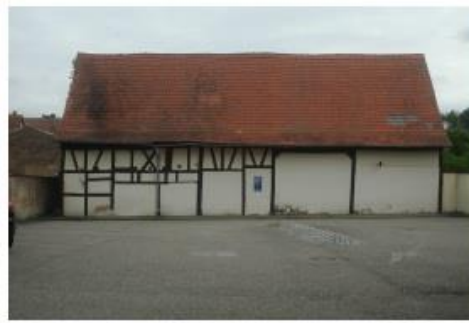
Grange (coté sud)
